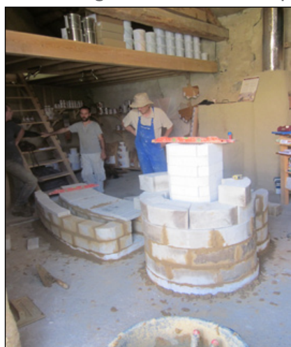
Le montage des éléments du poêle de masse
