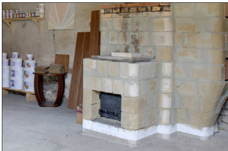
Poêle de masse réalisé au COCON, au cours du stage 2008
