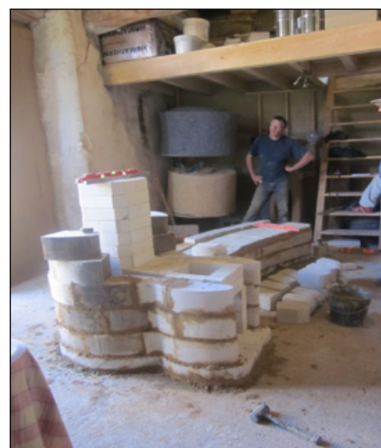
Le montage des éléments du poêle de masse
