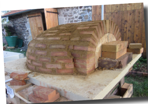
La construction d'un four à pain
